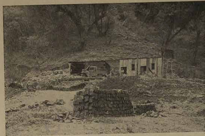
Iniciación de los trabajos en el campamento de arriba de "Farallón Blanco" en La Ramada (Tucumán).
