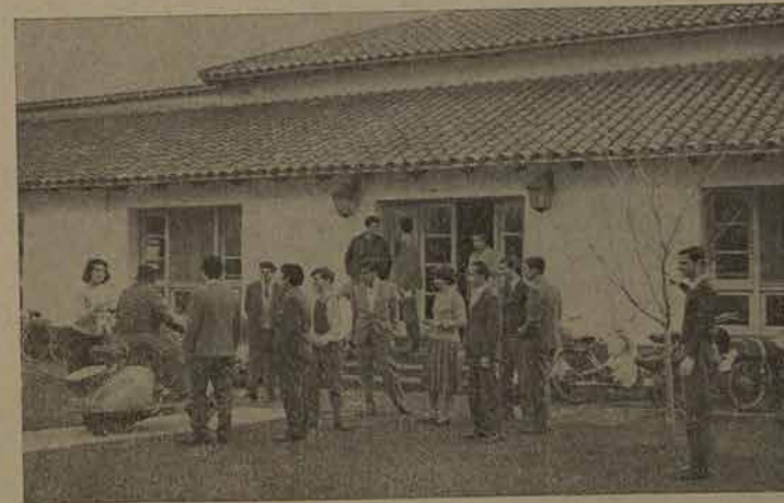
Al terminar la jornada los estudiantes de la Facultad de Arquitectura y Urbanismo abandonan el edificio sobre el costado sur.
