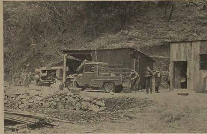
Emplazamiento del compresor y generador de corriente eléctrica en "Farallón Blanco", Tucumán.
