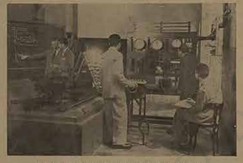
Parte de las instalaciones del Instituto de Electrotecnia.
