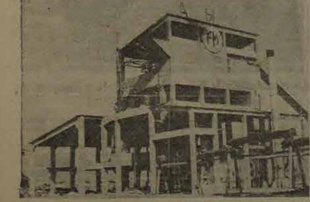
Otra vista de las instalaciones que la Dirección de Fabricaciones Nacionales tiene instaladas en la localidad de Palpalá, provincia de Jujuy, donde se trata el mineral de hierro procedente de las minas de Zepita.
