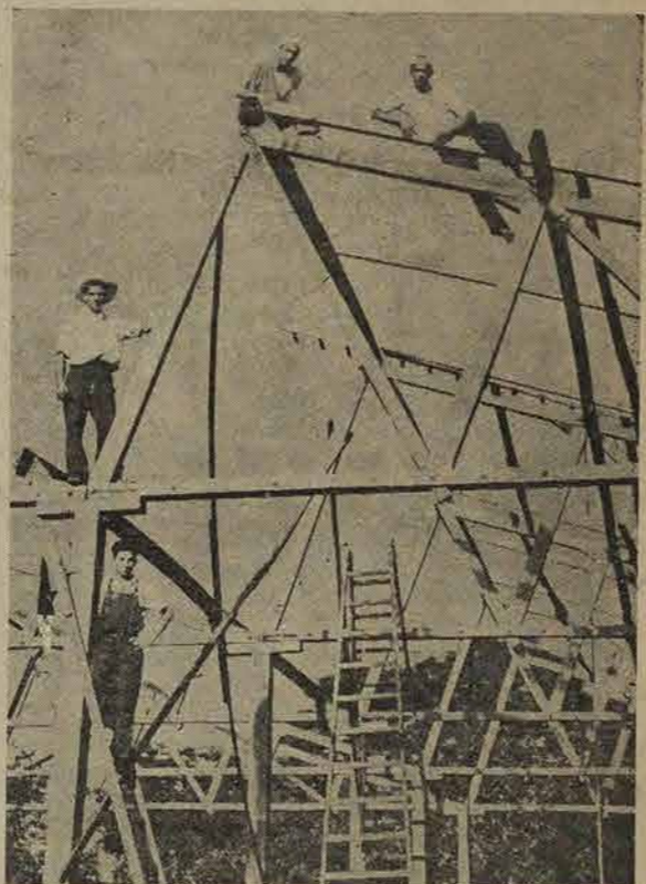
Alumnos del curso de construcciones realizan durante las clases practicas obras de gran alcance...
