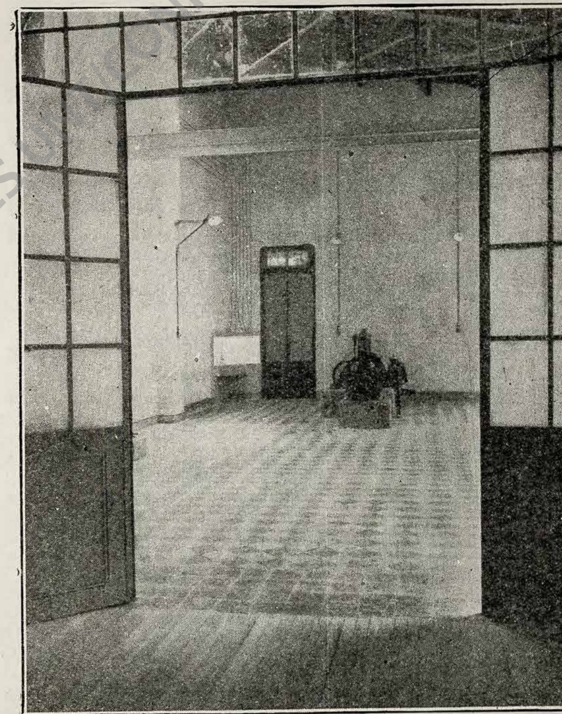
Nuevo salón de motores, mecánica, etc. Setiembre de 1923
